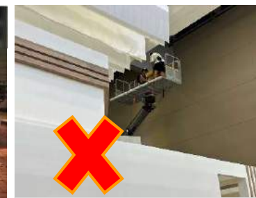
안전난간 임의해체 작업 안전대 미착용 작업
